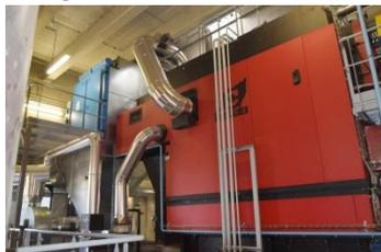
Le site de Purpan du CHU de Toulouse est équipé d'une centrale de production de chaleur biomasse qui permet de couvrir 90% des besoins en chaleur du site de Purpan, un dispositif qui s'inscrit dans la démarche de développement durable en privilégiant les énergies renouvelables et en réalisant, dans le même temps, des économies d'énergie significatives. L'exploitation de cette centrale a permis au CHU de Toulouse d'atteindre un taux de recours aux énergies renouvelables de 13,4%.
